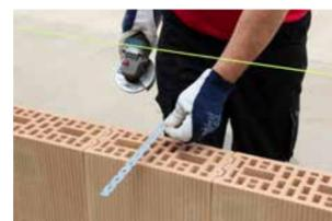
Liaisonnez les murs non-porteurs à l'aide de raccords galvanisés. Évitez la surépaisseur en entaillant légèrement la brique.
