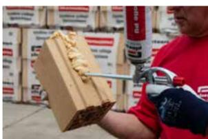
Encollez les joints verticaux des coupes de briques de dimensions inférieures à une demi-brique.
