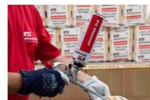
Ouvrir à fond la vis de réglage du pistolet et pulvériser afin de vider le pistolet de la mousse restante.
