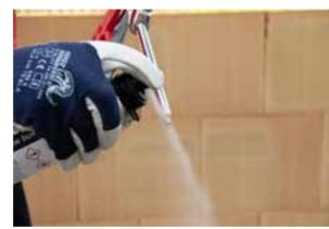
**Avant de reprendre le collage**, agitez l'aérosol au moins 20x. Desserrez à nouveau la vis de réglage.
