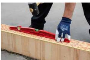
Contrôlez le niveau transversalement et longitudinalement.
