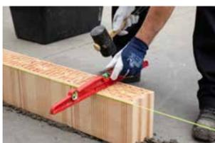
Maçonner la première couche **parfaitement de niveau** avec du mortier traditionnel. Utilisez des **Lambdablocs** rectifiés.
