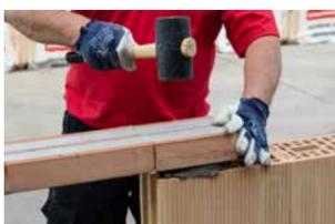
Scellez les linteaux au mortier traditionnel, régler l'aplomb.
