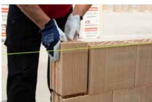
Évitez la recoupe en hauteur en utilisant différentes hauteurs de briques (13, 19 ou 25 cm).
