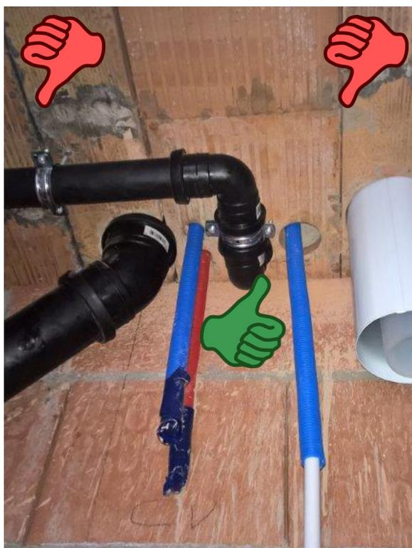
Pour le **Spanfloor**, le diamètre de perçage maximal est de 8 mm.
