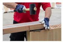
Utilisez du mortier traditionnel **en- dessous et au-dessus d'un linteau**pour une exécution parfaitement à niveau bulle.
