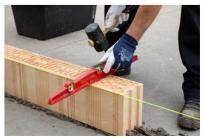
Maçonnez la première parfaitement de niveau avec du mortier traditionnel. Utilisez pour cela des Lambdabloc rectifiés.
