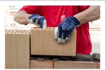
**Evitez le long sciage** des éléments de finition en utilisant différentes hauteurs de briques (13, 19 ou 25 cm).
